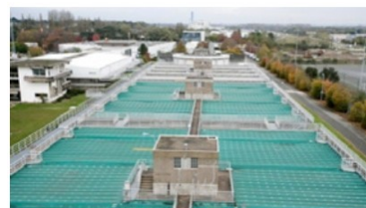
Usine de La Roche
