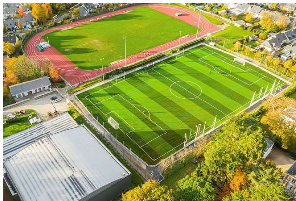
Terrain synthétique de l'Eraudière, remplissage en matériau naturel © Julien Gazeau pour Nantes Métropole
