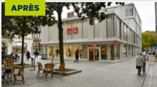
TRAVAUX D'EMBELLISSEMENT, ARRIVÉE D'UNIQLO EN MAI 2020, CRÉATION DE NOUVELLES SURFACES DE TERRASSES.
