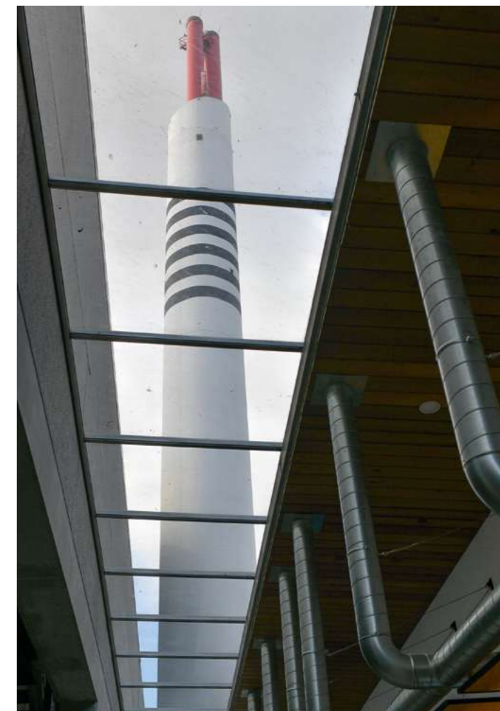
Cheminée de l'usine ARC EN CIEL 2034
