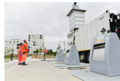
Source : Nantes Métropole – Point d'apport volontaire enterré
