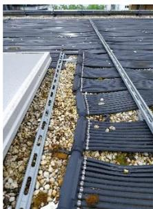
La nappe solaire est en mauvais état et n'est plus en eau. Il y a plusieurs raccords de cassés.
