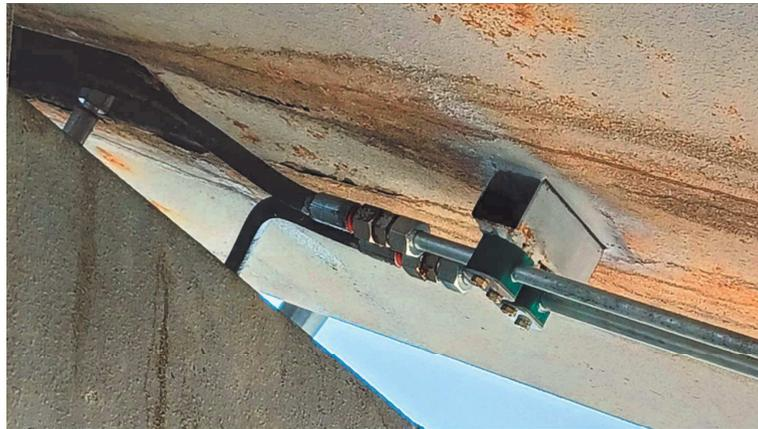
*Reprise des tubings de tension de chaine cendre humide des deux chaudières (en prévision du changement des vérins de tension)*
