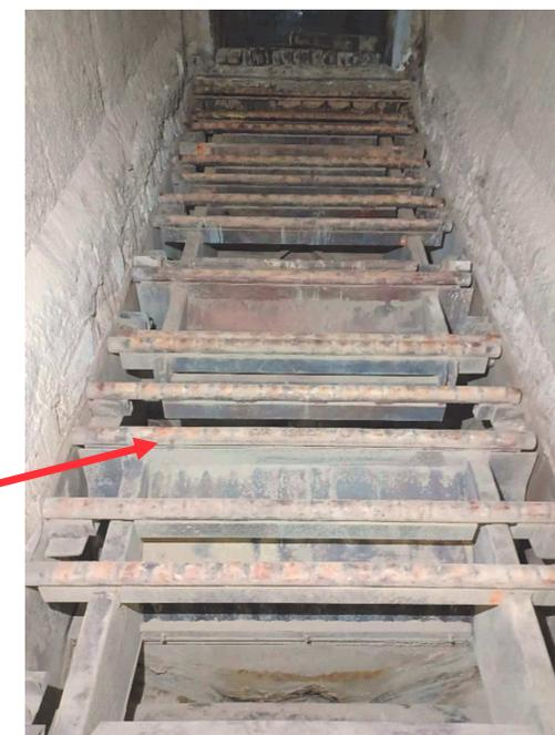
Barreaux déposés pour accès à la mécanique sous grille
