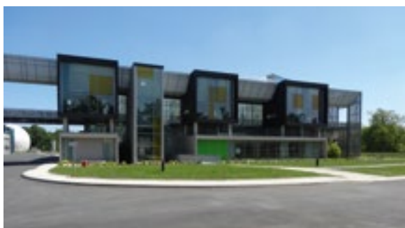
Station d'épuration Petite-Californie
