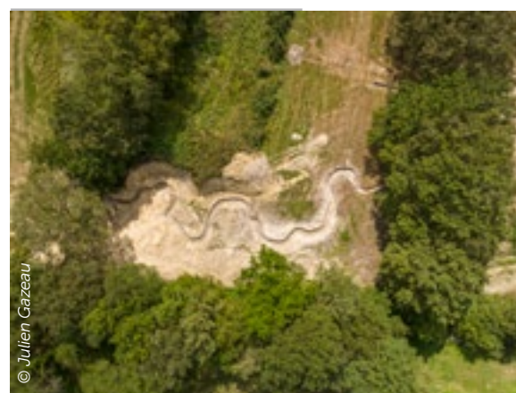
Travaux de reméandrage sur le ruisseau de la Ménardais (affluent du Gesvres)
