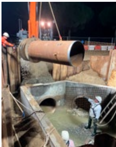
Travaux de nuit sur le chantier de la future ZAC Pirmil les Îles
