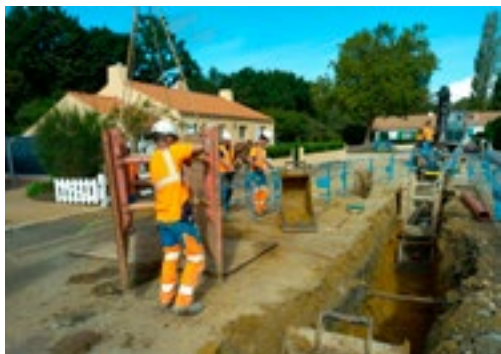
Renouvellement de réseaux d'eaux usées sur la commune de Bouaye
