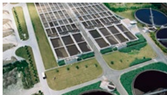
Station d'épuration de Tougas
