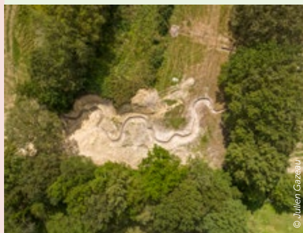
Travaux de restauration sur le ruisseau du Ménardais
