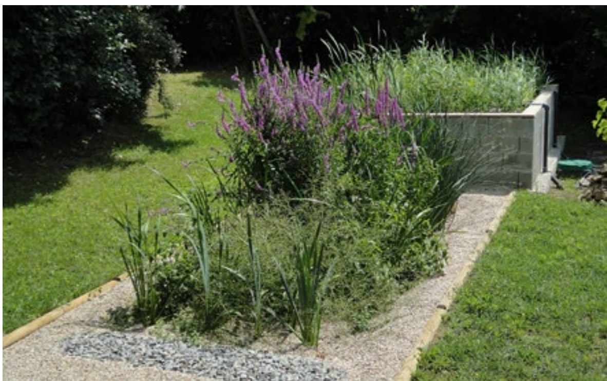
Filtres plantés, un assainissement non collectif naturel
