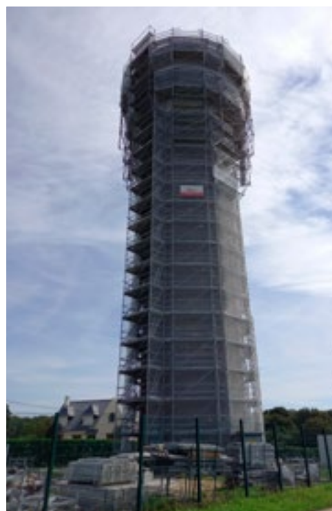
Travaux de réhabilitation du château d'eau de la Pilardière (Carquefou)
