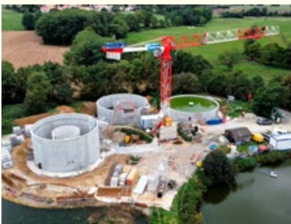
Travaux de la nouvelle station d'épuration de Brains
